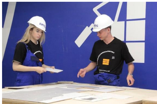
Рисунок 2 - Подготовка керамических плиток к укладке а - укладка плитки насухо; б - заданный рисунок облицовки
