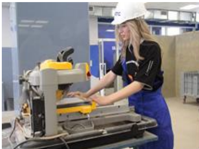
Рисунок 4 - Резка керамических плиток
